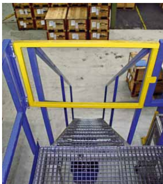
Fig. 23 Garde-corps en plusieurs parties. L'espace libre entre les différentes parties du garde-corps est au minimum de 75 mm et au maximum de 120 mm. On évite ainsi tout coincement involontaire de la main dans ces espaces.
