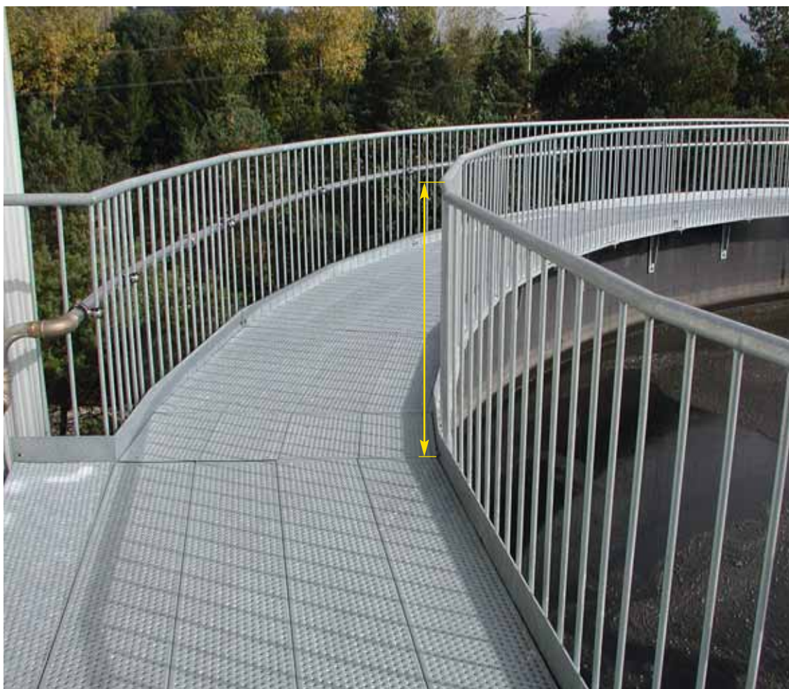
Fig. 10 La hauteur du garde-corps, du niveau de circulation au bord supérieur de la main courante, est de 1,1 m.
