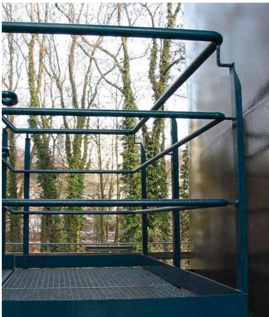
Fig. 14 Garde-corps de palier avec une main courante placée à au moins 100 mm du mur.
