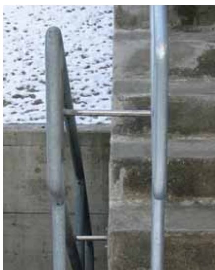
Fig. 14 Garde-corps de palier avec une main courante placée à au moins 100 mm du mur.
