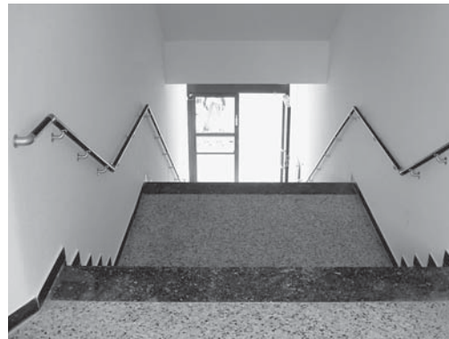
Fig. 1: contraste nécessaire pour garantir la visibilité des marches et des mains courantes.
