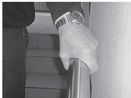
Fig. 2: 40 mm de diamètre pour une main courante ergonomique.
