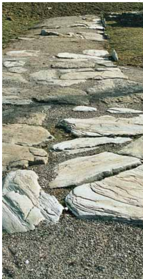
Rue romaine à Martigny
