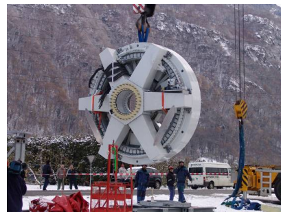
Figure 16 : Levage du générateur annulaire.
