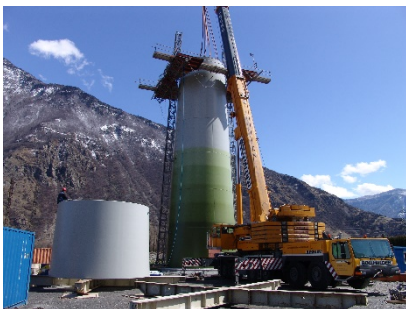
Figure 15 : Construction du mât.
