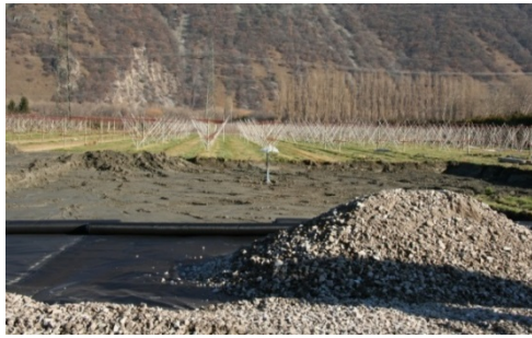
Figure 13 : Préparation de la place de chantier.
