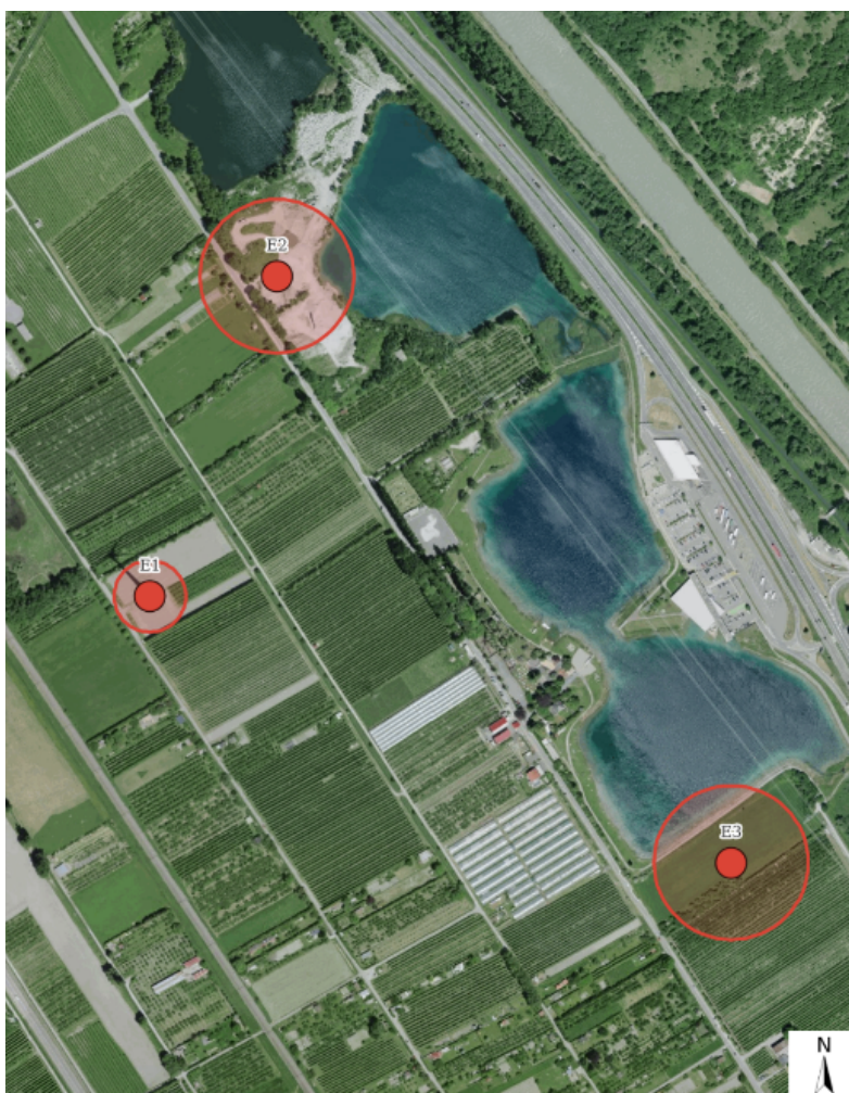
Figure 1 : Vue aérienne du site éolien Courtis Neufs figurant les emplacements des éoliennes existantes (E1) et prévues (E2, E3), à proximité du relais du St-Bernard (A9) à Martigny. Source adaptée : vsgis.ch.
