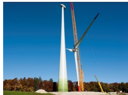
Figure 18 : Mise en place du rotor.
