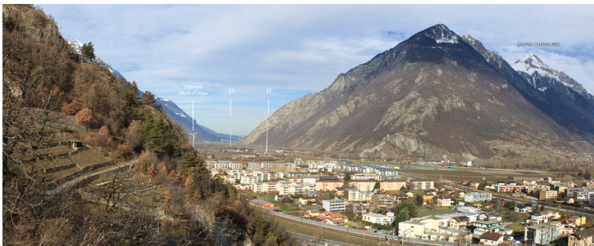
Figure 43 : Photomontage depuis la tour de la Bâtiaz à Martigny (point 3). Distance approximative à l'éolienne la plus proche visible sur le photomontage : 2,1 km. Source : Profil Paysage Sàrl.
