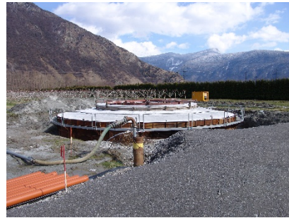
Figure 14 : Construction de la fondation.
