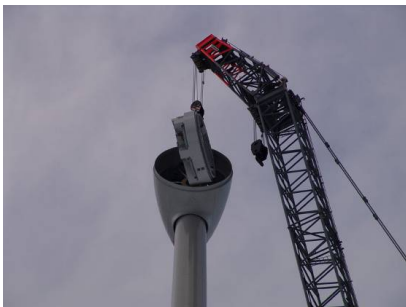
Figure 17 : Mise en place du générateur dans la nacelle.
