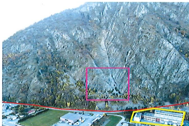
Figure 2 : Vue du site depuis le nord-est, avec la digue de protection contre les chutes de pierres, la route cantonale La Bâtiaz-Salvan (en rouge) et l'usine hydroélectrique d'Emosson SA (en jaune).
