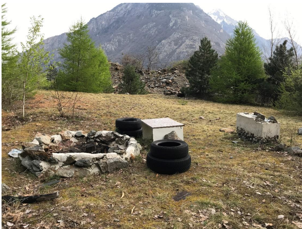
Figure 12 : Déchets et foyers sur le replat à l'arrière de la digue de protection (Silvaplus SA, 13.04.2022).
