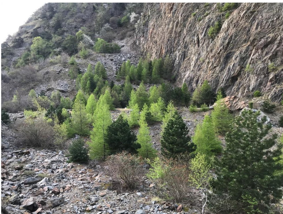
Figure 8 : Mélèzin et végétation vasculaire des parois siliceuses sur le replat à l'arrière de la digue de protection contre les chutes de pierres (Silvaplus SA, 13.04.2022, vue depuis la partie ouest de la future décharge).
