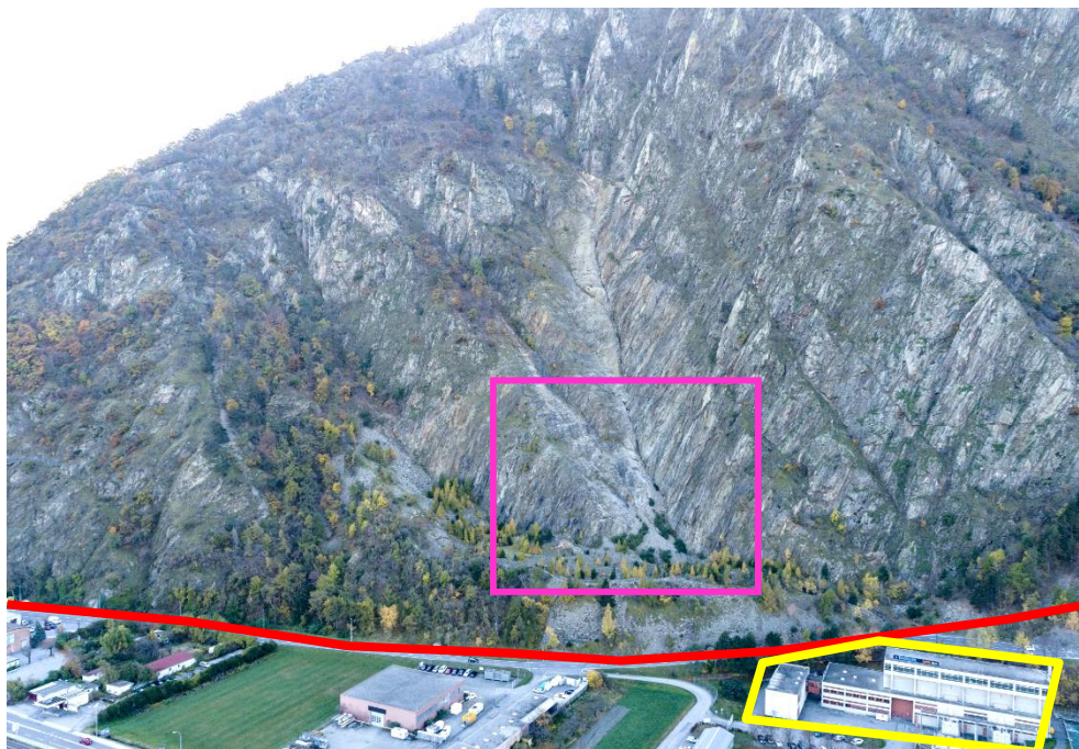
Figure 1 : Vue du site depuis le nord-est, avec la digue de protection contre les chutes de pierres, la route cantonale La Bâtiaz-Salvan (en rouge) et l'usine hydroélectrique d'Emosson SA (en jaune).
