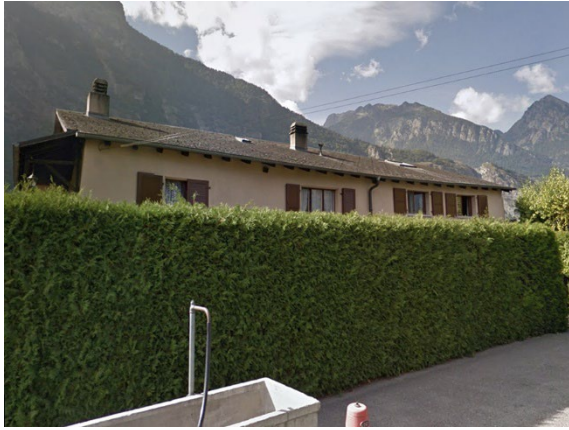
1 – Habitations, chemin du Milieu 101, Martigny.
