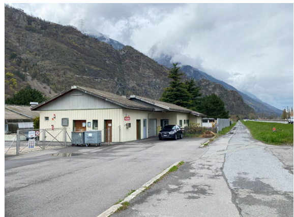
7 – Bâtiment partiellement à usage d'habitation, Maraiche de la Croix 1, Martigny.
