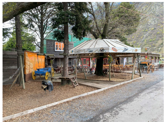
16 – Bâtiment commercial, route des Iles 8, Martigny.
