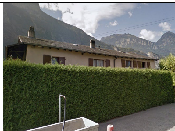
2 – Habitations, chemin du Milieu 101, Martigny.
