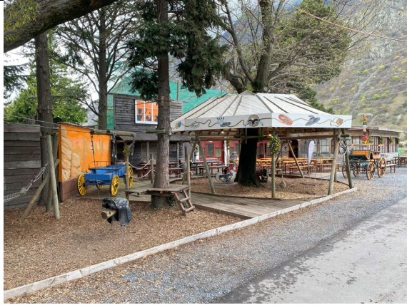
10 – Bâtiment commercial, route des Iles 8, Martigny.
