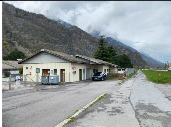
19 – Bâtiment partiellement à usage d'habitation, Maraiche de la Croix 1, Martigny.
