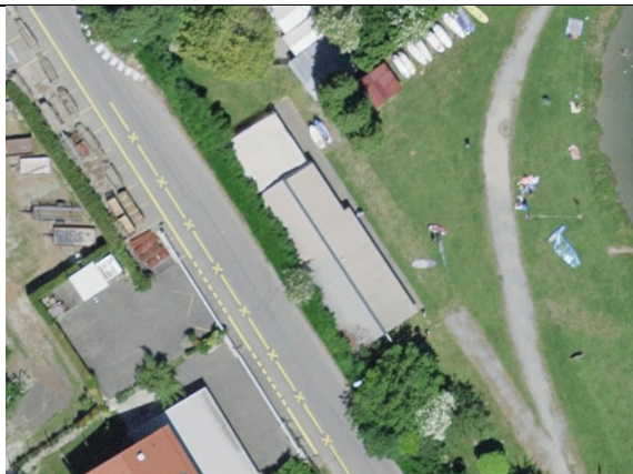
9 – Bâtiment à usage récréatif, route des Iles 6b, Martigny.
