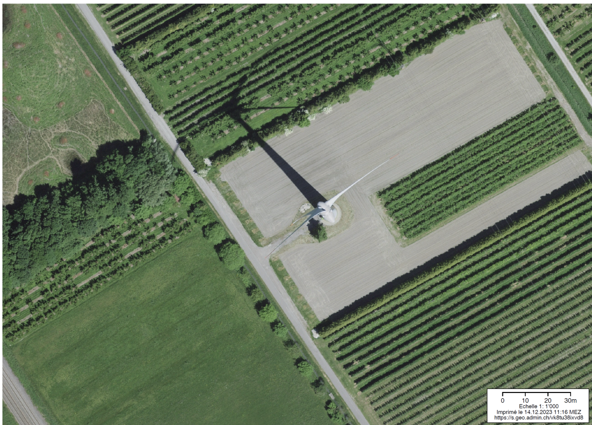
Figure 17 : Vue aérienne avec l'éolienne E1 Mont d'Ottan. Après les travaux, l'activité agricole originale a été reprise sur les aires de chantier (production fruitière, cultures). Seuls subsistent au sol le chemin d'accès et l'emprise du mât et de la fondation. Les emprises définitives sont reportées sur le plan de la figure 10 en page 13. Source : geo.admin.ch
