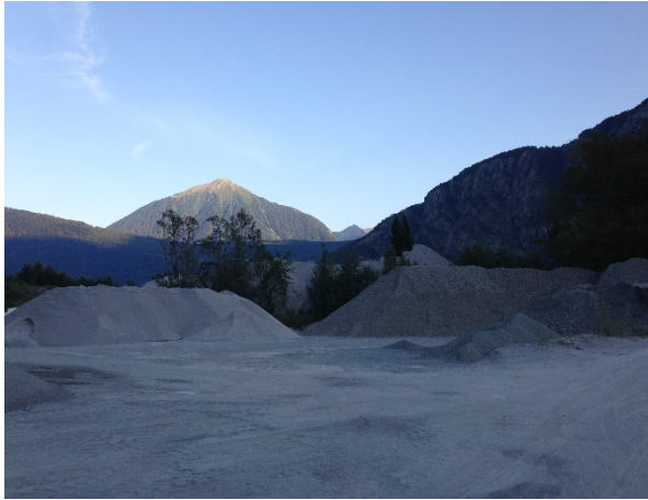
Figure 23 : Stockage des matériaux de construction à l'emplacement prévu pour l'éolienne E2.
