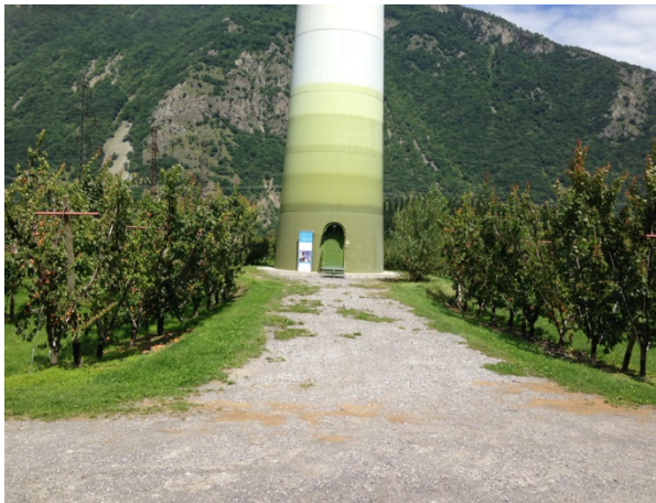
Figure 18 : Chemin d'accès de l'éolienne E1 Mont d'Ottan en phase d'exploitation.
