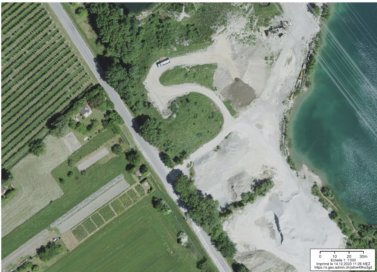
Figure 22 : Vue aérienne de la zone de construction de l'éolienne E2 Les Sables, utilisée pour le stockage des matériaux d'excavation et débris de construction. Les emprises définitives sont reportées sur le plan de la figure 11 en page 14. Source : geo.admin.ch
