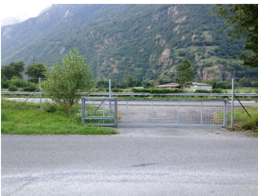
Figure 6 : Sortie d'entretien à Vernayaz reliant l'autoroute A9 et la route des Iles.
