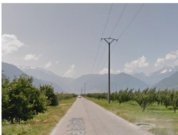
Figure 12 : Dans le cadre de la construction du « Parc éolien de Charrat », il est prévu de mettre sous terre le tronçon « Braeburn – Quiess » de la ligne aérienne de moyenne tension passant à proximité de l'éolienne E2 (risque de collision pour l'avifaune).
