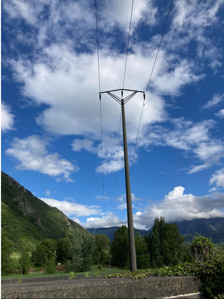
Photo 25 : Pylône 2 – Ligne Pylônes 102 à 101
