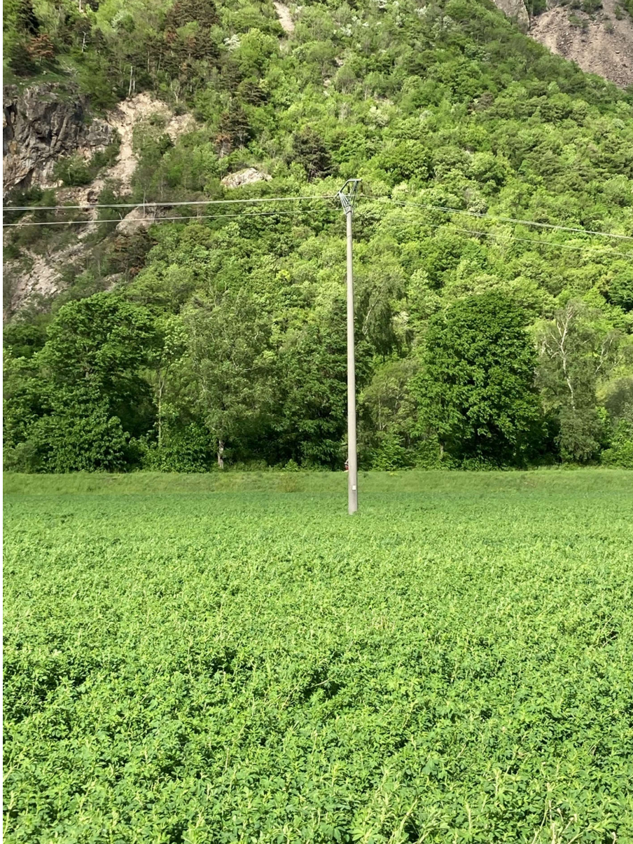
Photo 26 : Pylône 3 – Ligne Pylônes 102 à 101
