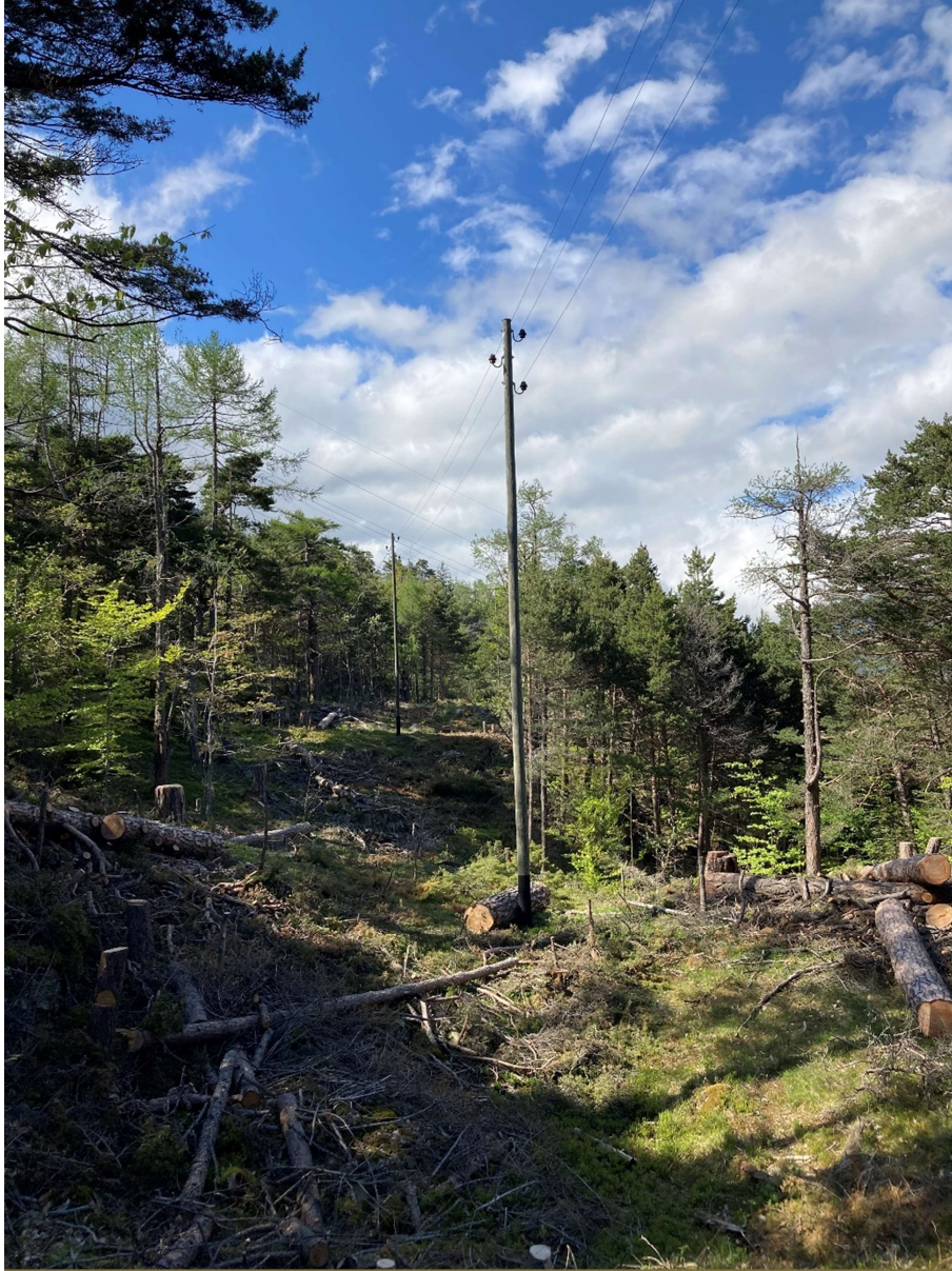
Photo 16 : Pylône 6 – Ligne Couplage Raverasses – Carrière Marin
