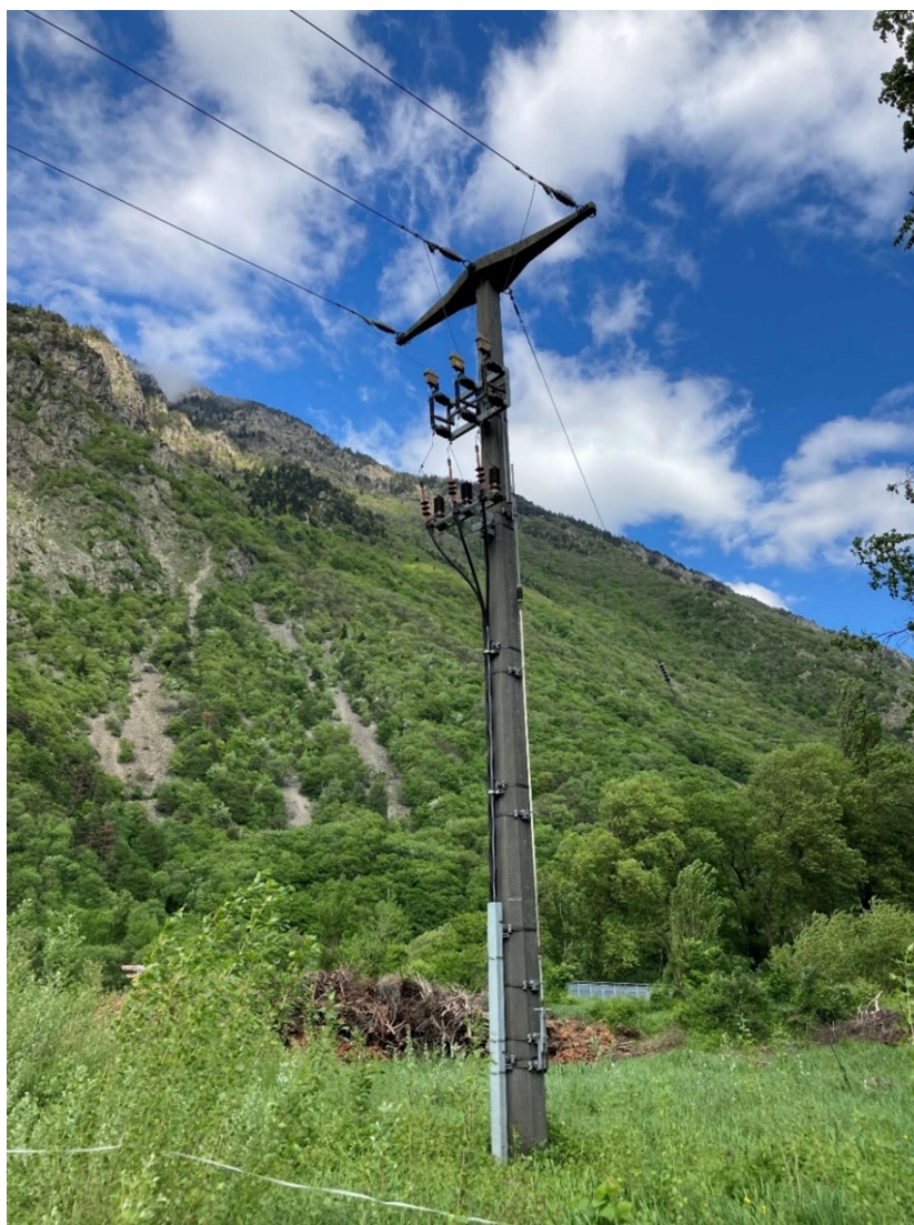
Photo 24 : Pylône 1 – Ligne Pylônes 102 à 101
