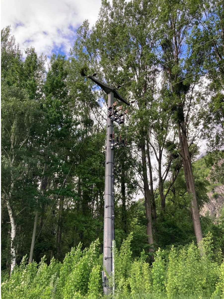
Photo 27 : Pylône 4 – Ligne Pylônes 102 à 101
