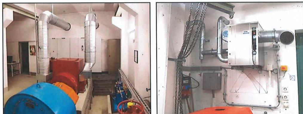
Nouvelles canalisation pour l'air de refroidissement    Appareil de déshumidification
